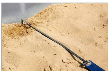
Le terrain est délimité par des rubans de 5-8 cm de large. Cette délimitation consiste en une sangle polyester qui présente un très faible pouvoir gonflant et une faible extension. La sangle est fixée aux quatre coins par des cônes de fixation ou des plaques de béton enterrés dans le sable de jeu. Ces éléments de fixation sont reliés par une corde élastique avec les marquages de terrain ou par des cordes élastiques sur crochets fixés sur la bordure.
