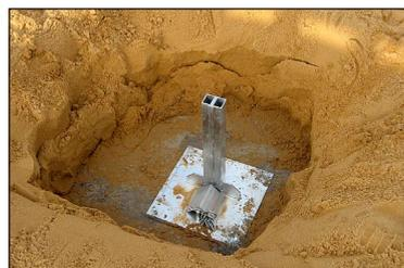
Le support peut être retiré de la plaque du pied en desserrant le boulon et en sortant du côté de l'ancrage de la plaque de pied.
