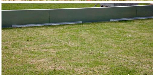
4.6 L'élément de stabilisation est connecté et vissé sur le joint des deux éléments standard et de l'élément précédemment placé.
