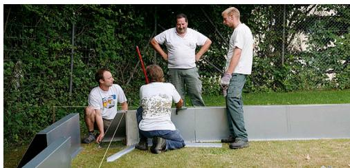
4.1 Deux éléments de liaison sont reliés avec l'élément d'angle et fixés sous le périmètre avec un écrou hexagonal.
