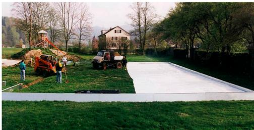
5.1 Pour obtenir une construction parfaite il faut également placé la couche de séparation (Géotextile) entre le sol et le sable. La bobine à habituellement une largeur de 250 cm. Les tapis non-tisé sont posés avec un recouvrement d'environ 15-20 cm.
