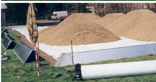
5.3 Si le sable sera livré après la pose de l'installation, la bordure doit avoir une ouverture de sortie. Aussi à noter que les câbles de tension d'acier sont posé.
