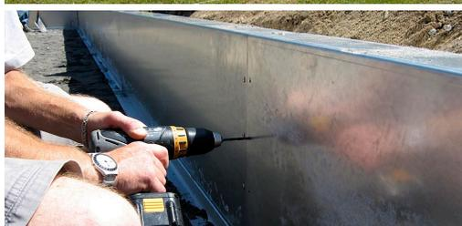
4.9 Sur chaque côté de la bordure est fourni un élément variable sans la tôle de guidage. Ces derniers sont énumérés sur le plan de construction. Après que tous les éléments sont placés, la construction est alignée et ensuite resserrer les vis très fermement.
