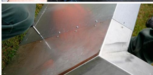
4.11 Utilisé pour la stabilité de la construction également le *silisport*-kit de tension, alors les côtés sont mutuellement soutenus ensemble.
