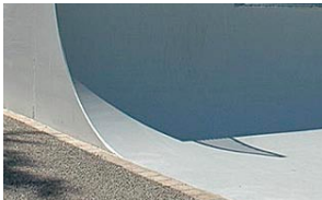
Lors de la création de nouveaux skateparks, les éléments de béton sont posés sur des fondations filantes et les pistes arrivent directement dans le revêtement d'asphalte ou de béton, sans tôle.
