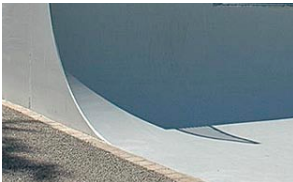
Bei der Neuerrichtung von Plätzen werden die Betonelemente auf Streifenfundamente versetzt und die Fahrflächen gehen ohne Bleche direkt in die Asphalt- oder Betonbelag über.
